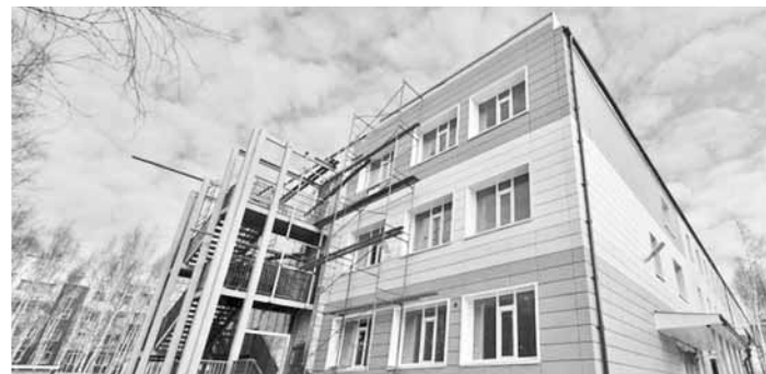
В 2023 году капитальный ремонт проведут в 9 объектах, текущий – в 16
