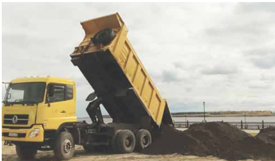
Начались работы по реконструкции городских набережных
