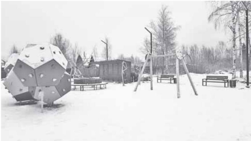
Работы почти завершены. Территория отсыпана и покрыта безопасной поверхностью, бортовые камни установлены, собрана большая часть малых архитектурных форм. Подрядчику осталось испытать систему уличного освещения, собрать детское игровое оборудование и установить беседку, в которой, кстати, будут розетки для зарядки смартфонов и точка доступа к бесплатному беспроводному интернету.
