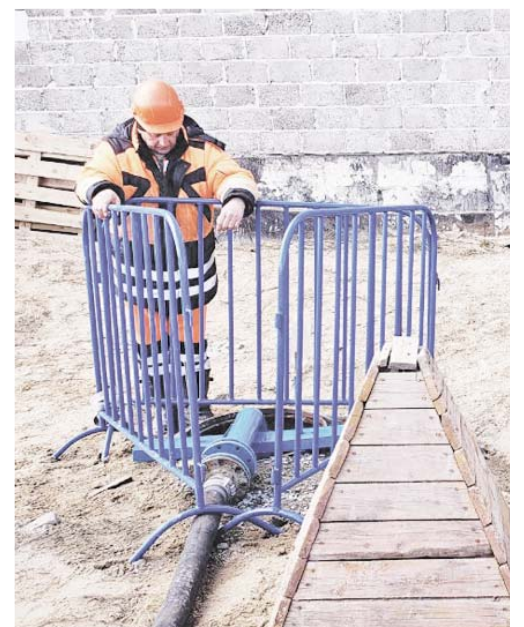
Промывка системы водоснабжения
