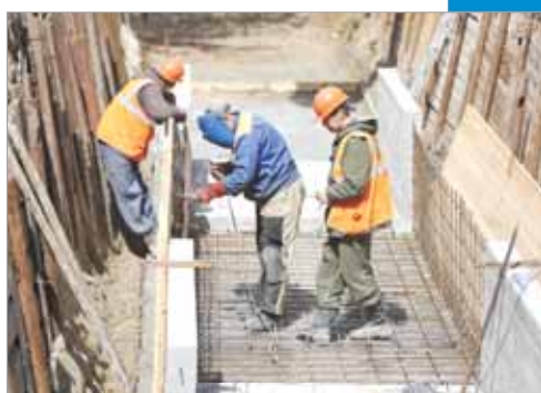
Началась ремонтная кампания
