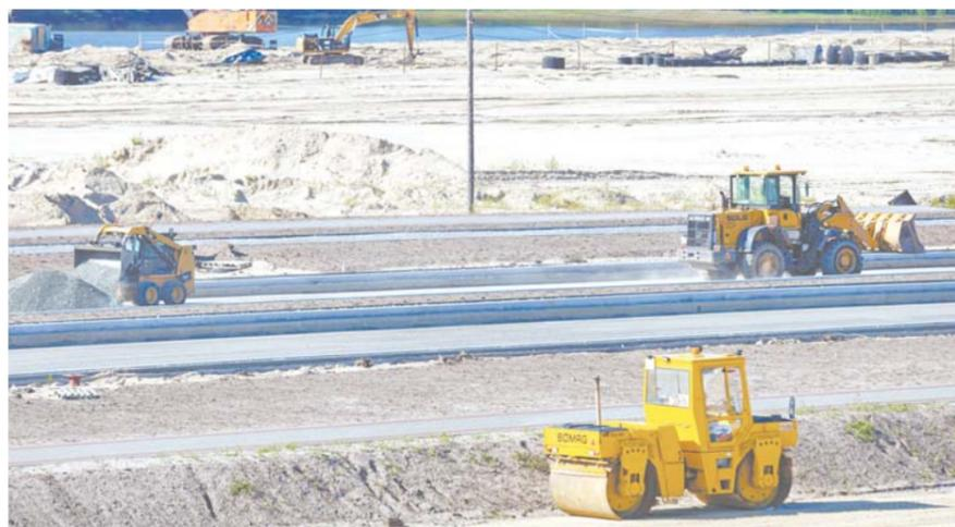
ливневой канализации. На сегодня готовность объекта – 60 процентов. Выполнена основная часть инженерных коммуникаций, уложены нижние слои дорожного покрытия, продолжается устройство тротуаров.
