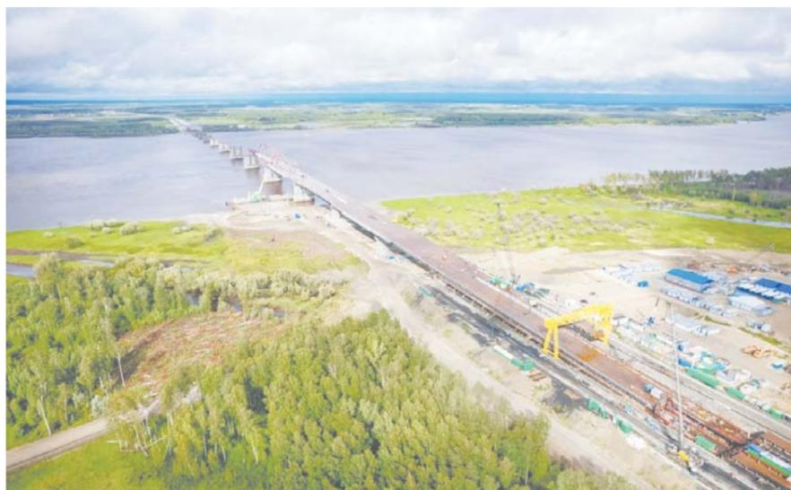
с правого берега с 13-й по 16-ю опору. На данном участке уложен нижний слой асфальтобетона, заасфальтированы тротуары, выполняются работы по укреплению водозащитной дамбы, грунтовке и покраске пролётного строения.
